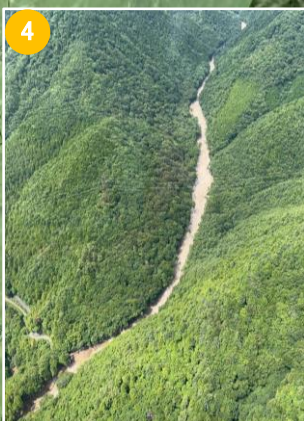
中房国有林の状況 土石流による溪岸侵食が確 認されました。
