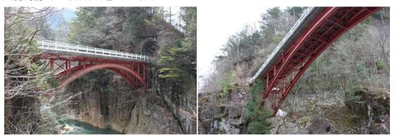
王滝森林鉄道の大鹿渕に架かる鋼上路リブアーチです。鉄道の鋼アーチとしては最初期 のものだと言われています。現在は林道橋として利用されています。(大正 12 年竣工)
