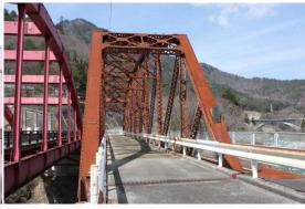
鬼淵鉄橋は木曽森林鉄道の遺構の中でも最大級のものです。大正時代になって日本の鉄橋(トラス橋)は鋼材から製作まで国内の技術で作ることができるようになりましたが、この鬼渕鉄橋が現存する国産最古のトラス橋だと言われています。昭和 50 年まで森林鉄道の鉄橋として使われましたが、森林鉄道の廃止後、林道用の橋に改造されて使われました。平成8年に下流側に新しい道路橋が完成したため、廃橋となりました。
