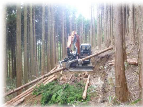
(プロセッサによる枝払・造材作業)
