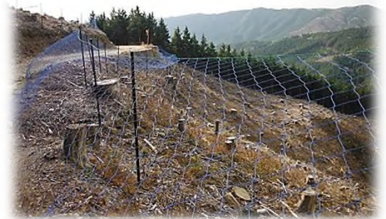
(シカ防護柵の設置)
