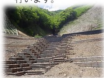
間伐材の使用(床固工)
