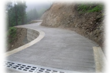
(新設林業専用道)
