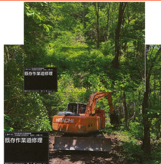
高密度路網の修繕前及び修繕中
