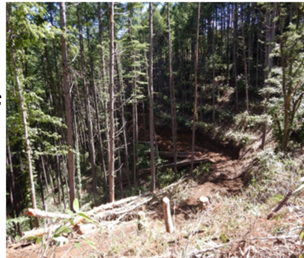
伐前地拵を行い、作業道を作設した。
