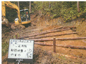
森林作業道作設
