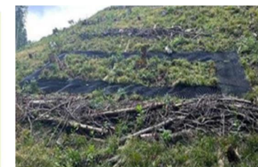
特殊樹脂ネットの設置
