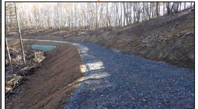
平成29年度 東信森林管理署 四方原林業専用道新設工事
