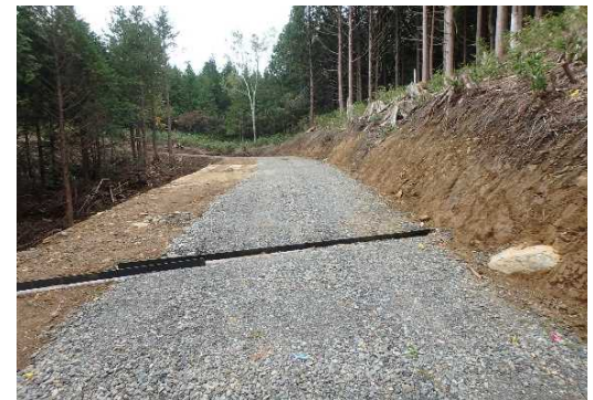
木曾森林管理署 クロブチ林業専用道新設
