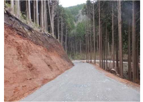
岐阜森林管理署 ミスリ林道 新設工事
