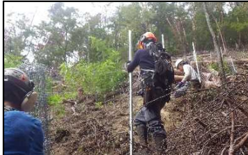
シカ防護柵設置作業
