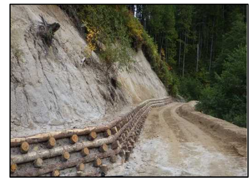
中信森林管理署 奈川黒川 改良工事
