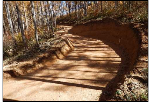
中信森林管理署 鹿島川 新設工事
