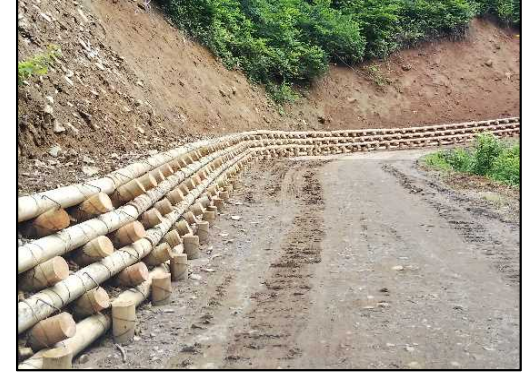
間伐材等を使用した丸太積工
