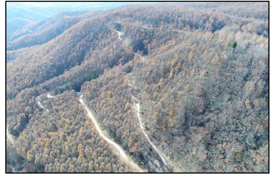
路網整備事業 (新設工事)
