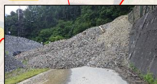
⑥ 青木川区域被災状況 (国道への土砂の流出)
