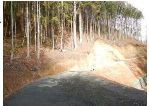
奈良井支線新設工事（奈良井国有林塩尻市）
