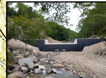
復旧状況(R5年)
