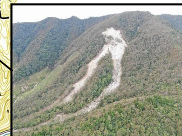
H30年に発生した崩壊地
