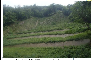
復旧状況(R5年)
