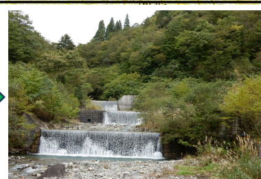
復旧状況(R5年)
