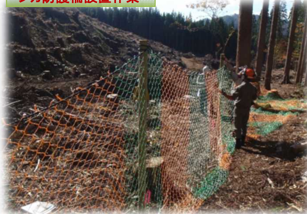
シカ防護柵設置作業
