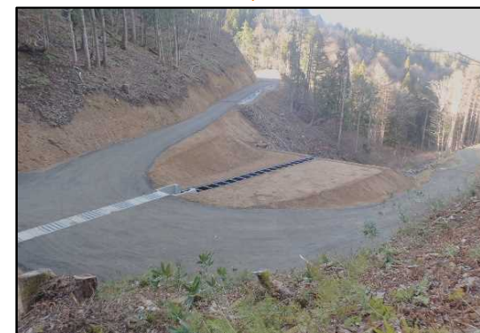
飛騨森林管理署 滝ヶ洞 新設工事
