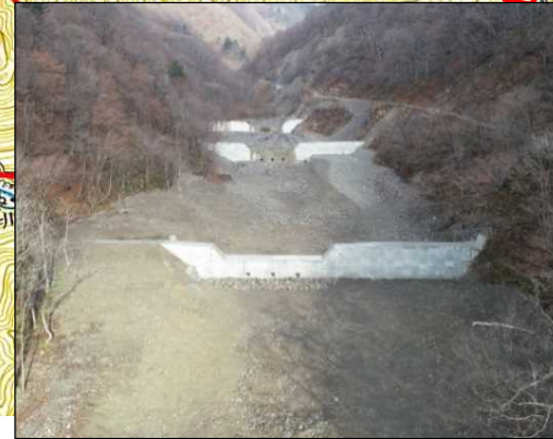
海ノ溝谷区域 溪間工
