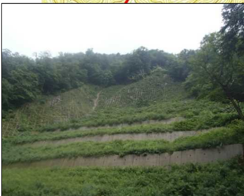
大ツゲ谷区域 山腹工
