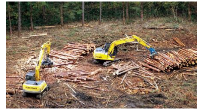
2台のグラップルの連携で 効率よく集造材する現場
