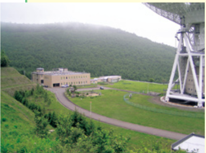
パラボラアンテナと関連施設
