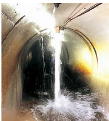
排水トンネル内の状況 (集水井からの排水)
