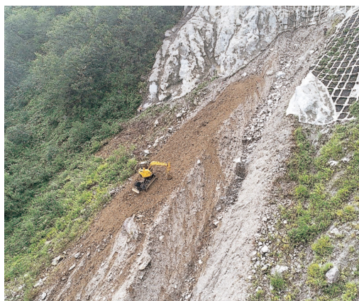
ロッククライミングマシンの施工状況
