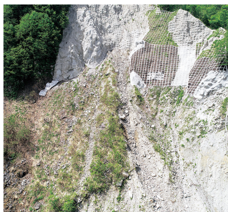
工事着手前の様子
