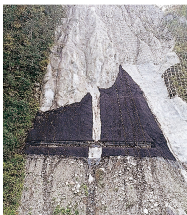
完成した工事
