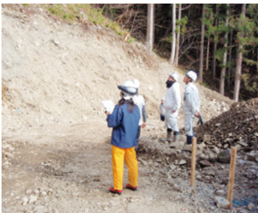
工事現場の立会確認中の筆者
