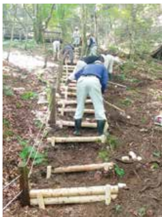
歩道整備の様子
