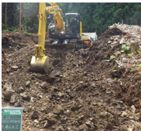
切土作業の様子
