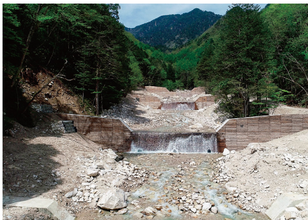
完成した谷止工工事現場の様子
