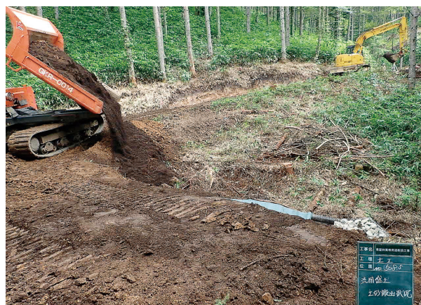
林業専用道新設工事の様子
