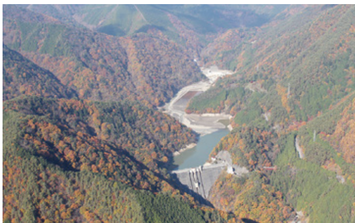
県営松川ダム
