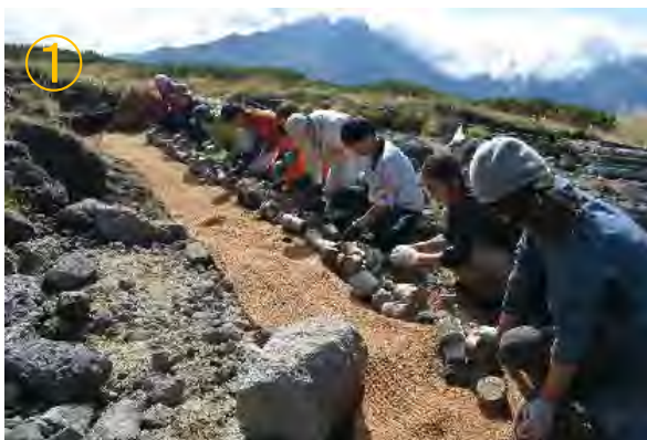
① ネットを敷き、転石を並べる
