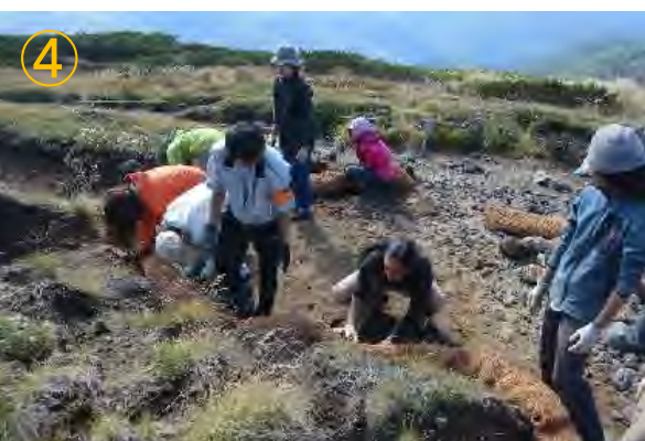
④ ロール状にしたネットを浸食面に密着させ固定する
