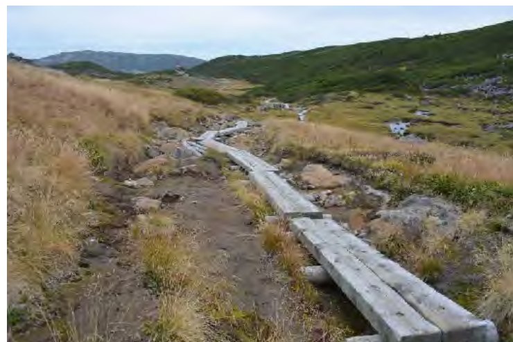
③施工8年後 2016.09.17
