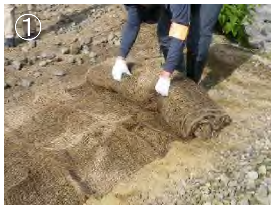
① 転石は除け、ネットは土壤面に密着させる
