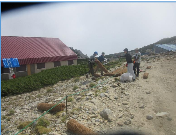
植生マット施工作業
