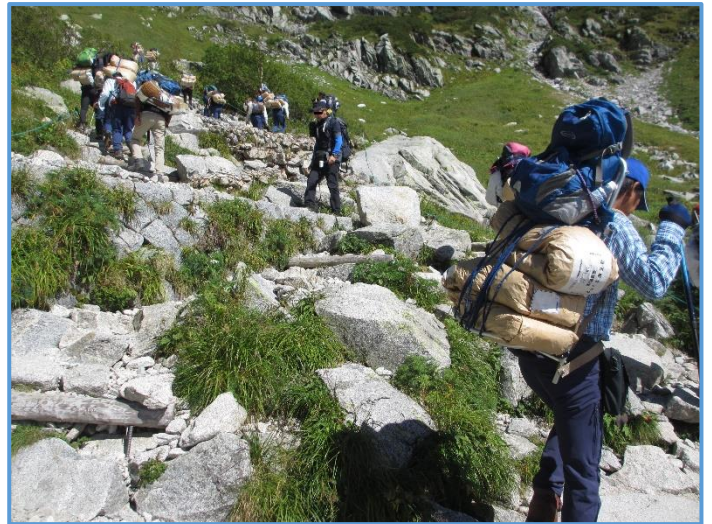
植生マットの荷揚げ作業
