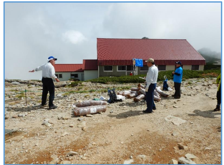
植生マット荷揚げ完了
