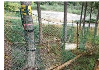
低コスト化を図るため 立木を利用した防護柵 (東濃署)
