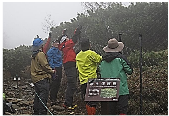
ボランティアによる高山帯での 防護柵設置作業(南信署)
