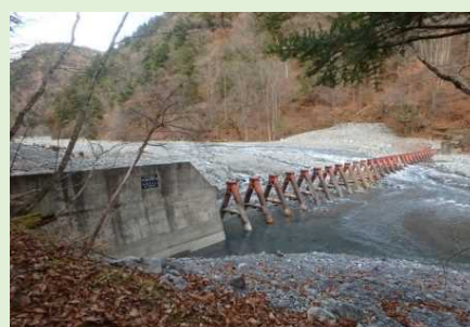
従来型の流木捕捉式治山ダム
