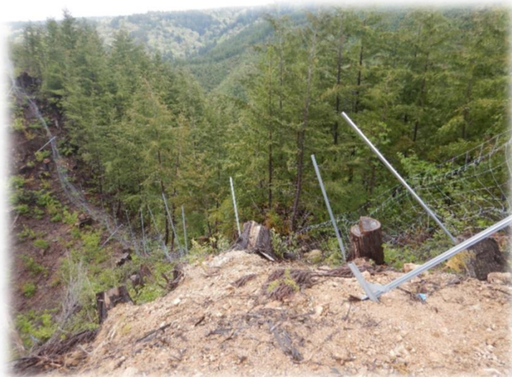
降雪による防護柵の破損状況
