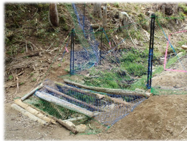
受け流す柵を参考に設置した箇所
