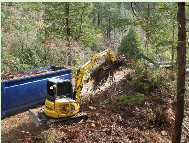
運搬車への積込み状況
