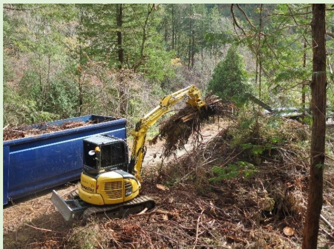
運搬車への積込み状況
