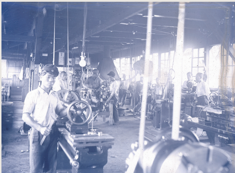
昭和初期頃、帝室林野局木曾支局上松出張所の機械修理工場内部
