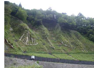
板取川地区（海ノ溝谷施工地） （岐阜署）
