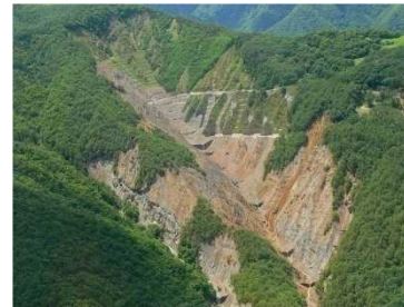
小渋川地区（鳶ヶ巣施工地） （伊那谷総合治山事業所）
