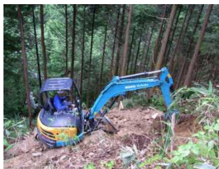
森林作業道作設(岐阜署)
