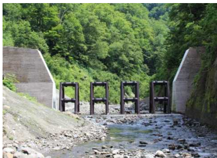
生物多様性に配慮した施工 （北信署）
