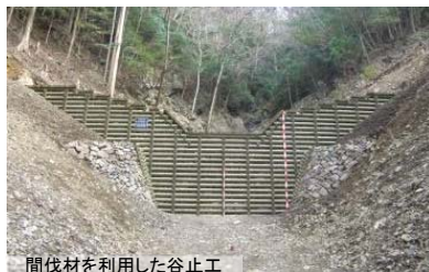
間伐材を利用した谷止工
