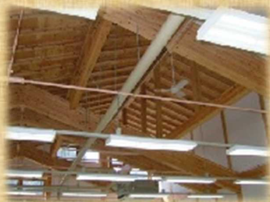
事務室ふきぬけ天井
