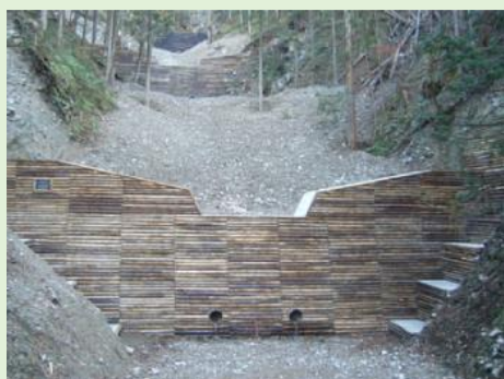
間伐材を利用した溪間工
