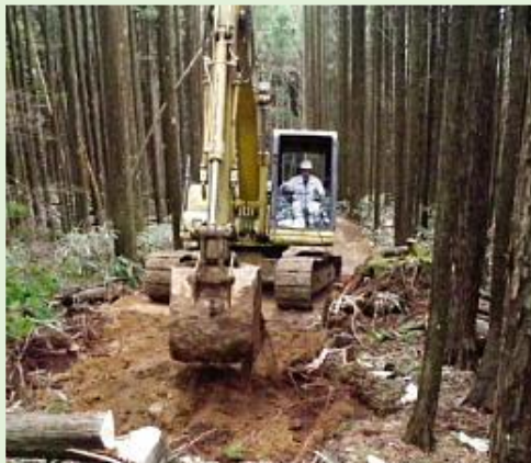
作業路網作設
