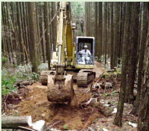
作業路網作設
