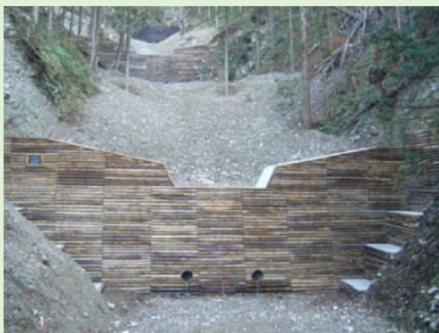
間伐材を利用した溪間工
