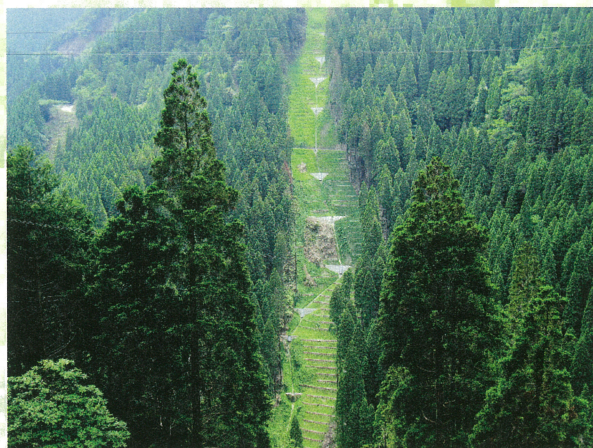
【平成27年度写真コンクール最優秀賞】 「山あいに見える山腹工」宮本満則(熊本県熊本市)
