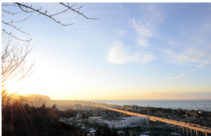
夕日に映える北陸新幹線高架橋
