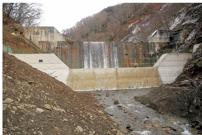
土谷川地すべり防止工事 完成状況
