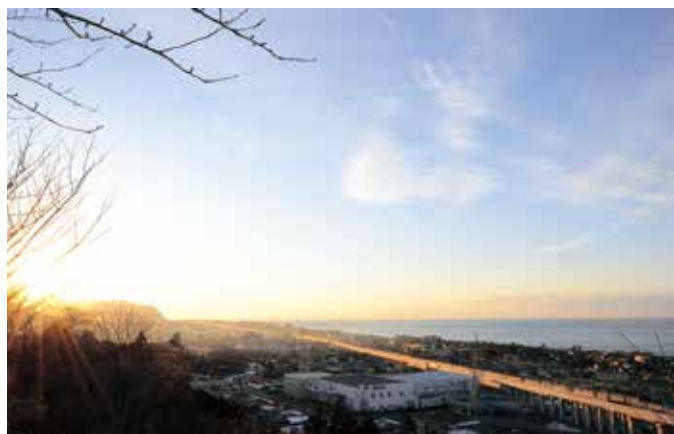
夕日に映える北陸新幹線高架橋
