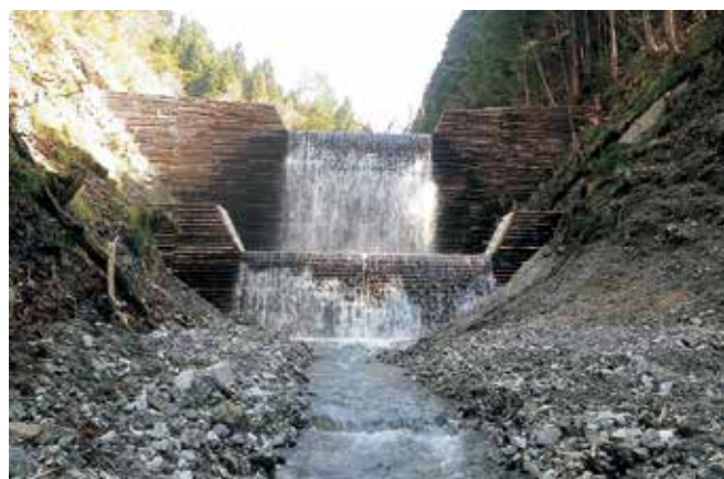
鍋割中ノ沢(中ノ沢)復旧治山工事 完成状況
