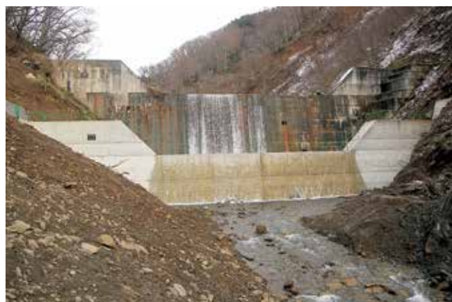
土谷川地すべり防止工事 完成状況
