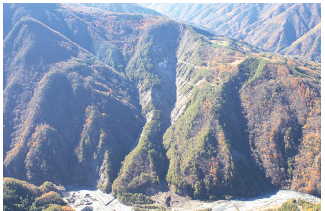
鳶ヶ巣（山腹工）
