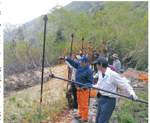
防鹿柵ネット張り替え作業の様子
