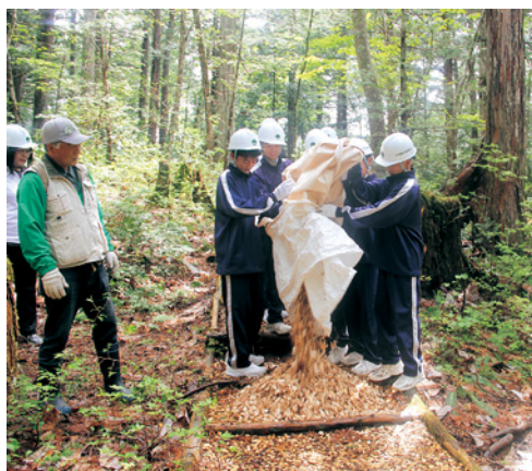
チップ敷設による遊歩道の整備
