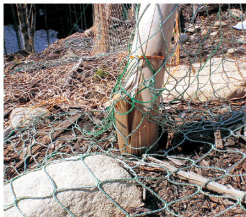
雪により折損したヒノキ支柱
