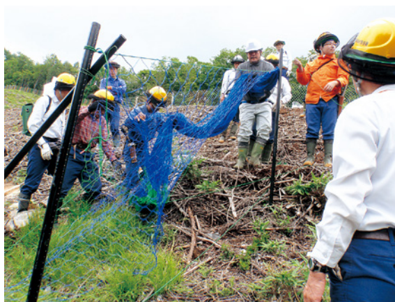
埼玉方式型シカ防護柵の設置
